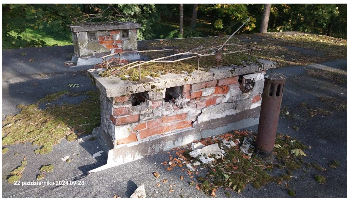
Dach z pokryciem z papy, istniejące kominy wentylacyjne
